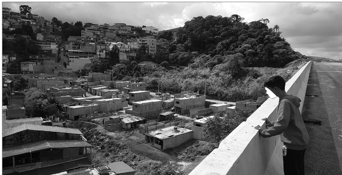
Figura 7 Ocupação às margens do trecho norte do Rodoanel, 2018.
